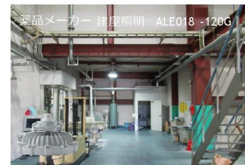
防爆水銀灯400Wから防爆無電極へ交換
